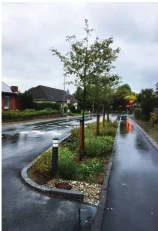
Figur 4-6 Eksempel på vejbed for lokal regnvandshåndtering
