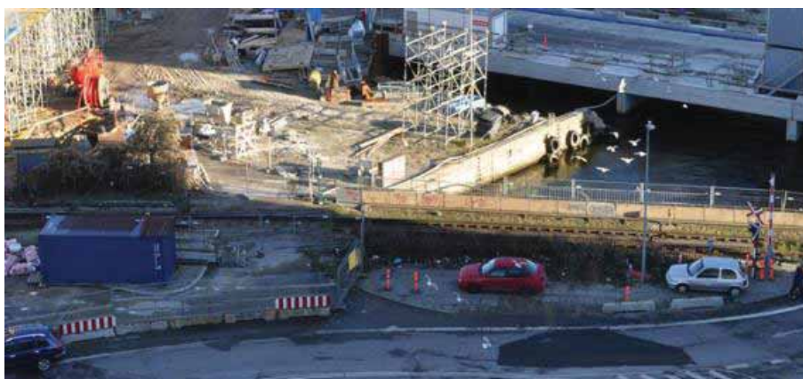
Figur 4-9 Eksempel på anlægsarbejde i forbindelse med Århus Letbane
